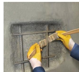
Nanošenje Sika Mono Top 910 na beton kao veza stari-novi beton
