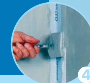
4 Nanošenje drugog zaptivnog sloja
