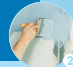
2 Nanošenje prvog zaptivnog sloja
