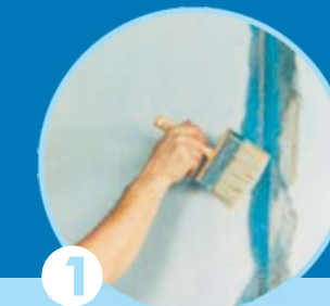
1 Priprema podloge
